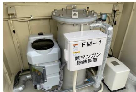
トイレの水は通常時も井水利用。停電時も非発の電気を使い、井水をくみ上げ、トイレの利用が可能となります。
